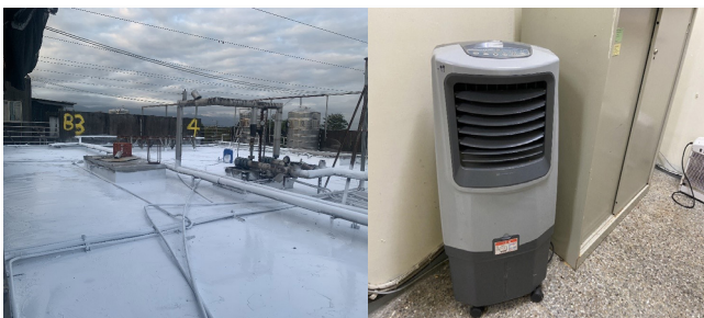
宜蘭收容所於頂樓施作冰漆工程有效緩解夏季高溫及防堵漏水並於收容區增設水冷扇調節室溫
