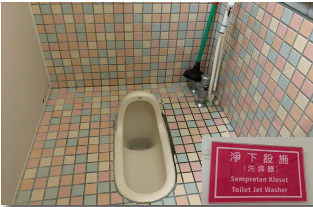
於廁所設置淨下洗滌設施
