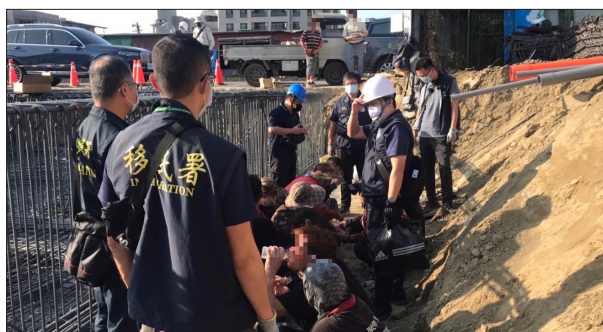
本署專勤隊於建案工程工地執行查察
