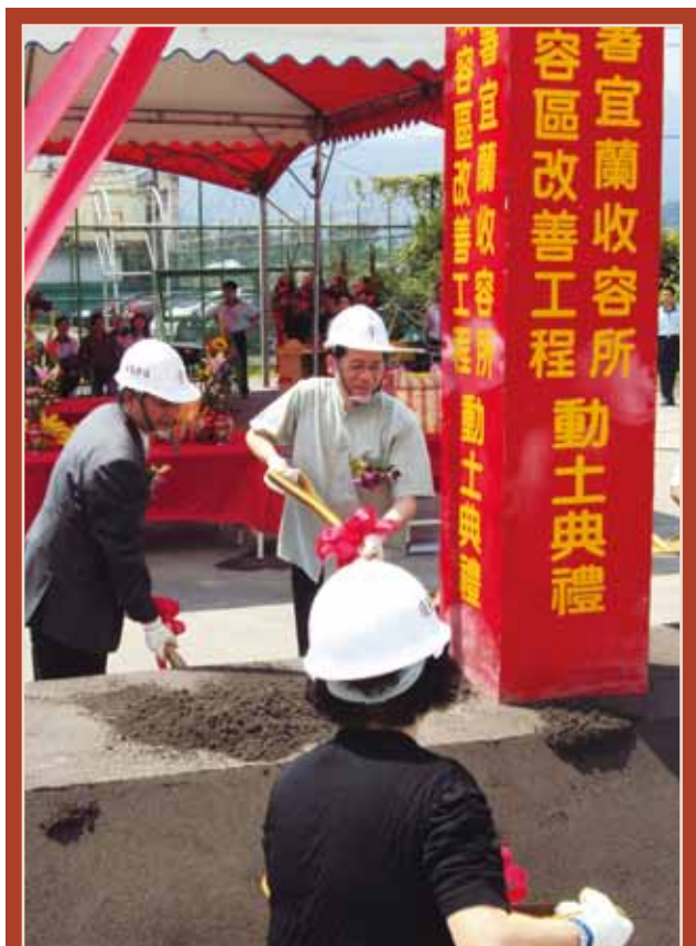
2011.05.11 移民署長謝立功與宜蘭縣長林聰賢(左)主持宜蘭收容所新建行政大樓及舊有收容區改善工程開工動土典禮
