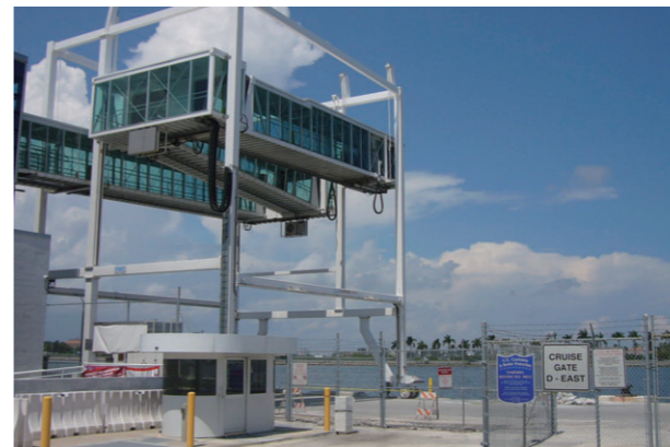
▲ 邁阿密港口是世界知名的遊輪港，便利的通關程序頗受好評。圖內的活動式空中走廊，使旅客完成報到及安檢程序後能直接從旅客大樓內部進入遊輪，設計相當便利。
