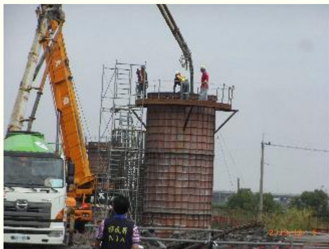
移民署屏東縣專勤隊同仁至重大工程處所查察非法外勞
