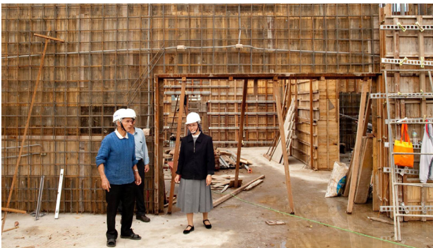
劉一峰神父（左）巡視怡峰園建造工程狀況及進度。
